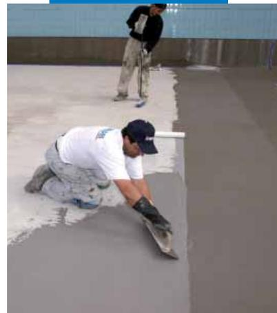
*Impermeabilización de una piscina con Mapelastic*
