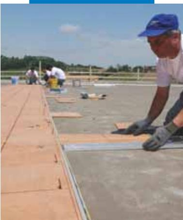
Colocación de cerámica con Kerabond + Isolastic
