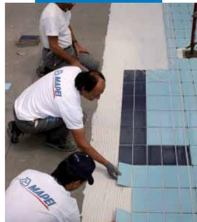
*Colocación de revestimiento cerámico sobre Mapelastic*
